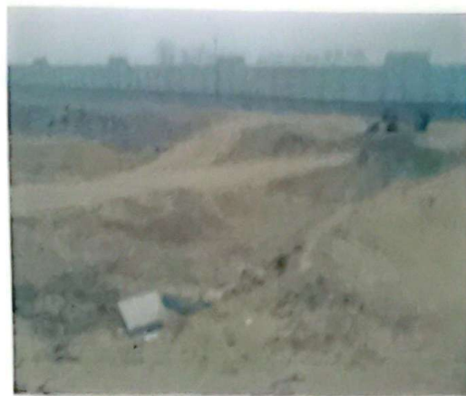
本项目现状图片
