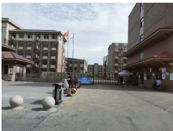
厂区东侧求实中学
