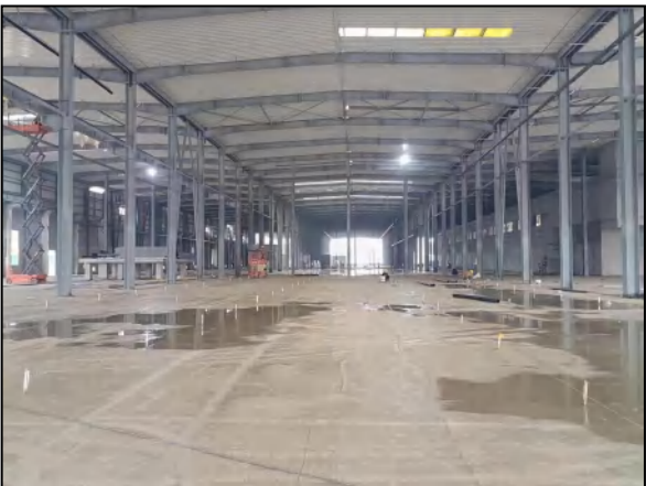
车间内部照片
