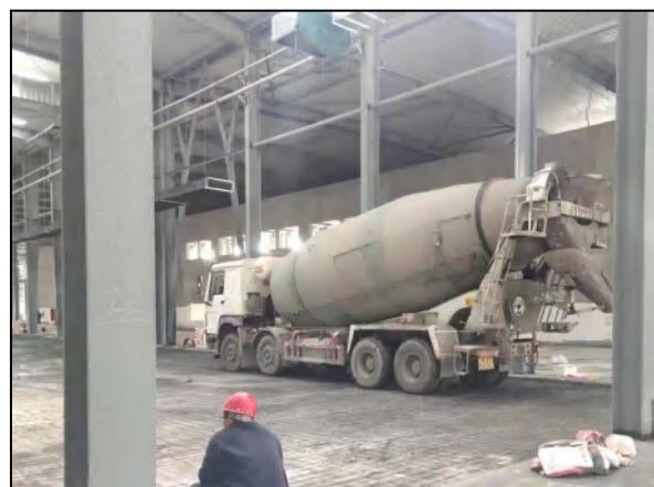
车间内部照片
