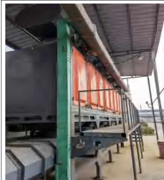
有机废气处理装置（活性炭吸附脱附+RCO+活性炭吸附）及 DA004 排气筒
