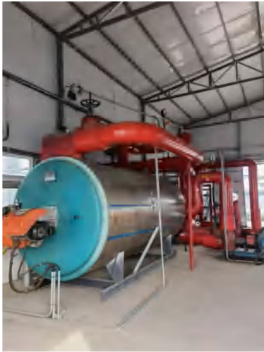
导热油炉（烟气再循环+低氮燃烧装置）及 DA005 排气筒
