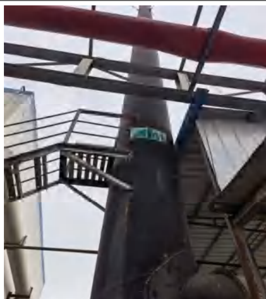
有机废气处理装置（活性炭吸附脱附+RCO+活性炭吸附）及 DA004 排气筒
