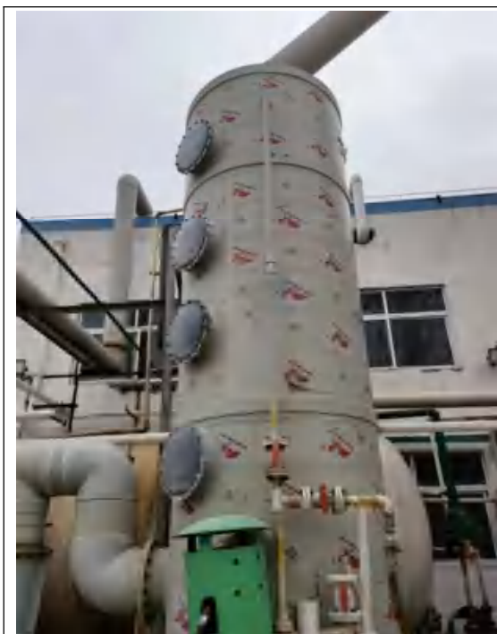
环合氯代车间（二车间）外多级降膜吸收装置及 DA002 排气筒
