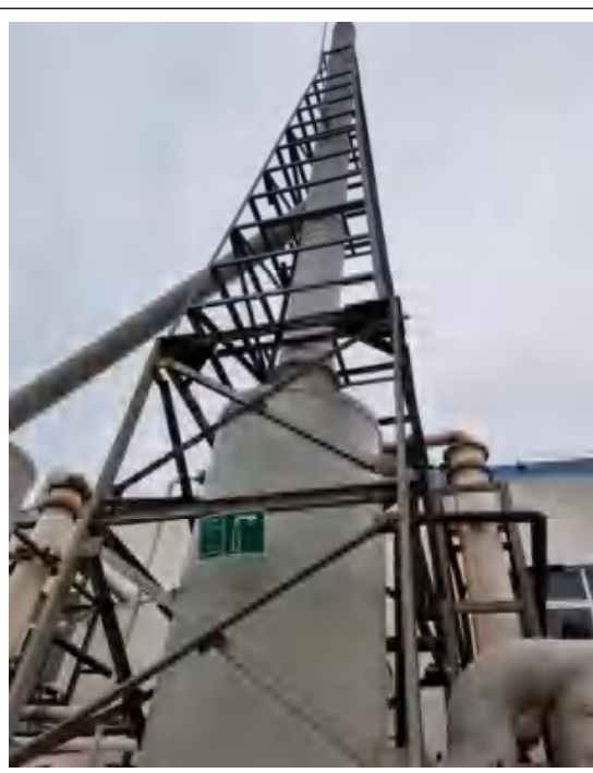
环合氯代车间（二车间）外多级降膜吸收装置及 DA002 排气筒
