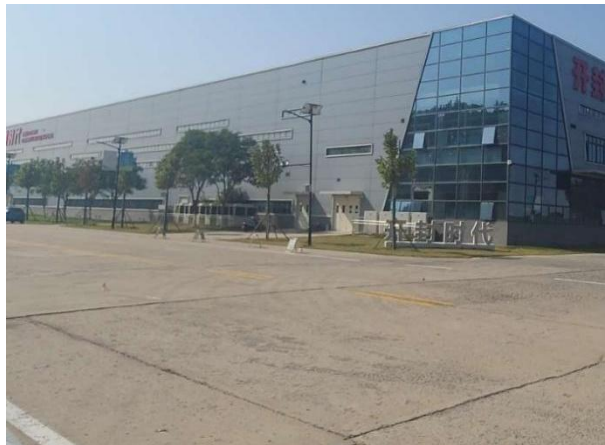
东侧储能产业园道路
