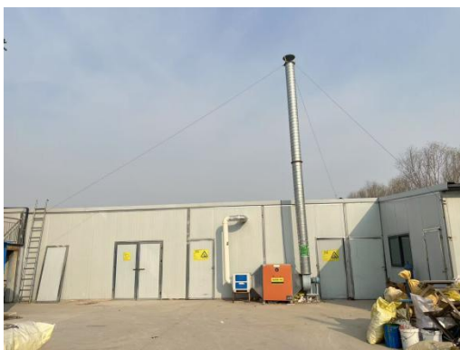
危险废物暂存间及配套污染防治措施
