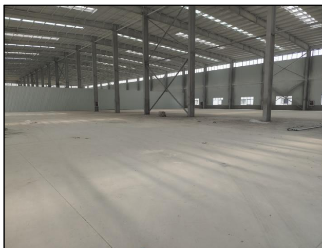
车间内部现状
