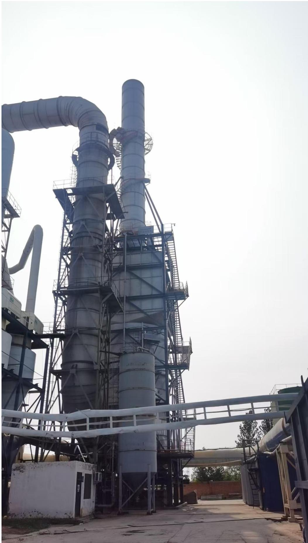
2、改造前颗粒物排放浓度为  $25.71\text{mg}/\text{m}^3$ ，风量为  $226000\text{m}^3/\text{h}$ (数据来源为检测报告),改造后排放浓度为  $4.2\text{mg}/\text{m}^3$ ,风量为  $225000\text{m}^3/\text{h}$ (数据来源为检测报告),企业年生产时间为  $7200\text{h}$ ,通过计算,企业改造前颗粒物排放量为:  $25.71 \times 226000 \times 7200 = 41.83\text{t}/\text{a}$ ,企业改造后排放量为:  $4.2 \times 225000 \times 7200 = 6.8\text{t}/\text{a}$ ,综上所述,企业减排颗粒物为  $41.83 - 6.8 = 35.03\text{t}/\text{a}$ 。
